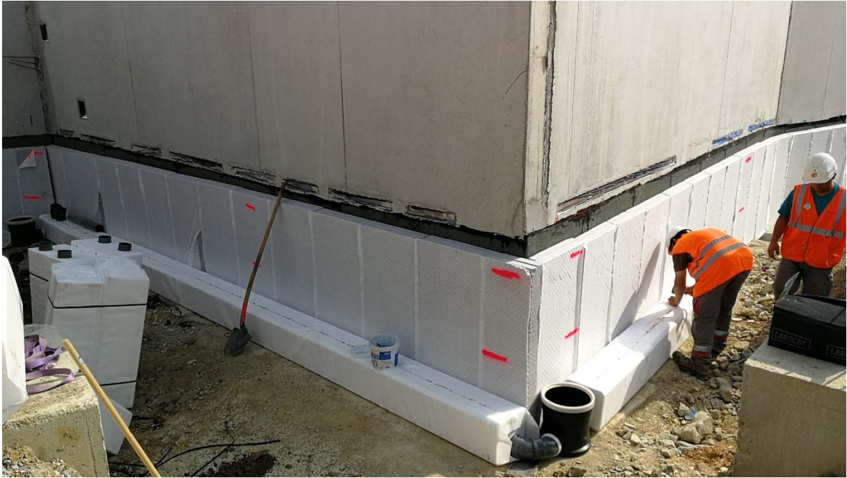
Figure 9 : Exemple d'une pose de réseaux CLIPCEN
