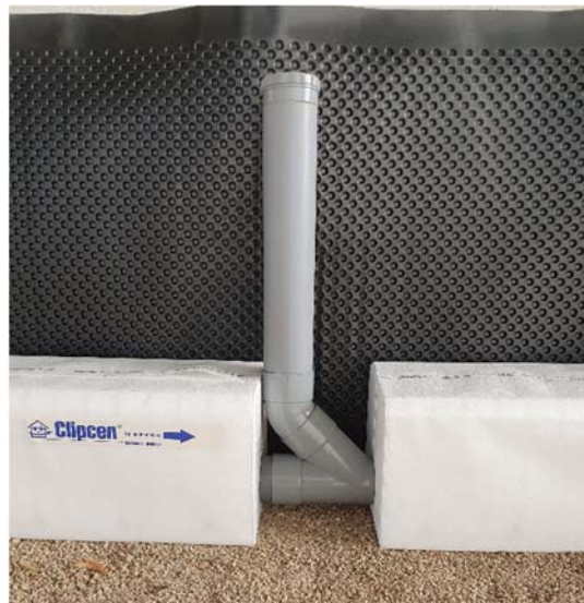
Figure 6 : Exemple de système d'inspection CLIPCEN de type cheminée
